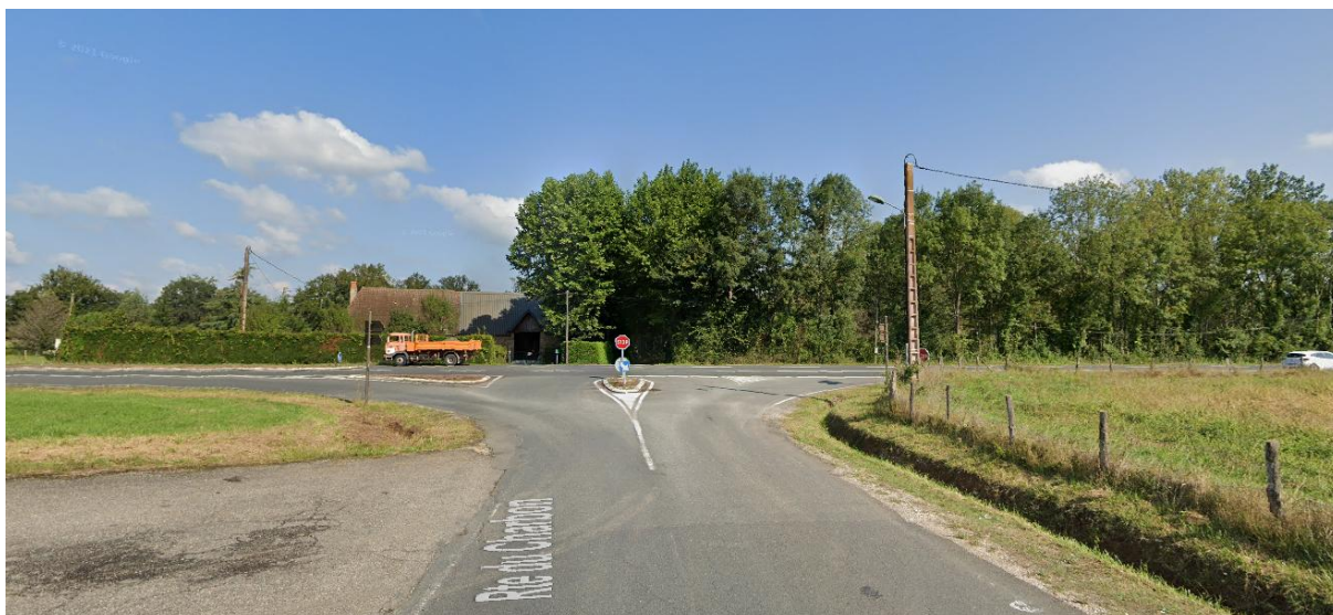
Intersection dégagée entre la route du Chaudron et la RD 6089. @Google Map
