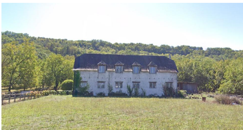
Bâtiment artisanal au centre du site
