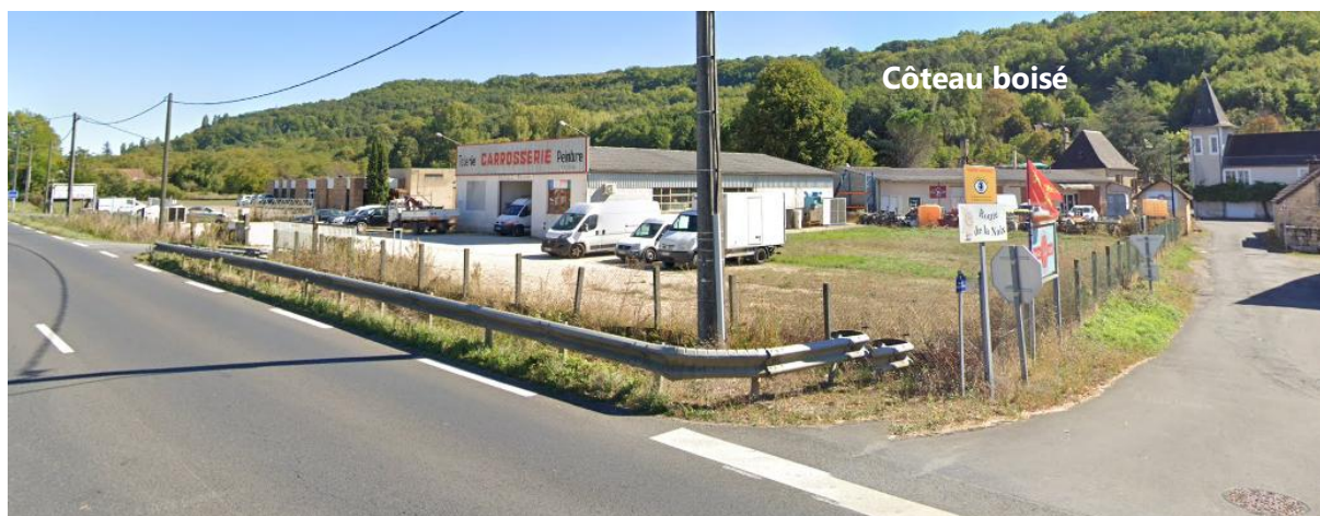
Perception visuelle depuis l'arrivée ouest de la RD 6089 (depuis Terrasson) @Googlemaps
